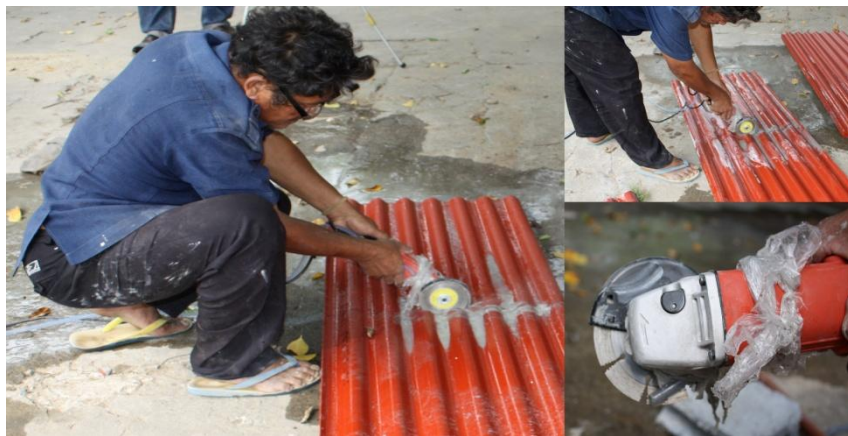
การฉีดน้ำดักฝุ่นขณะตัดกระเบื้อง
