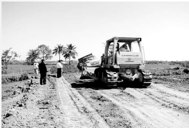
การเตรียมพื้นที่สำหรับงานก่อสร้าง
